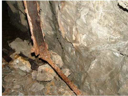
088) Deep Adit – pump-rod angle piece
